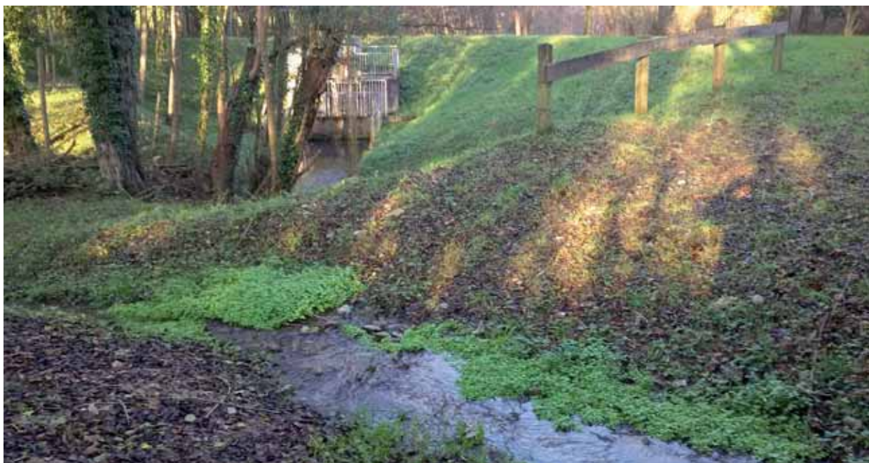
Geschlitzter Damm, der das Wasser aus dem Mühlengraben unmittelbar in den Wildbach leitet
