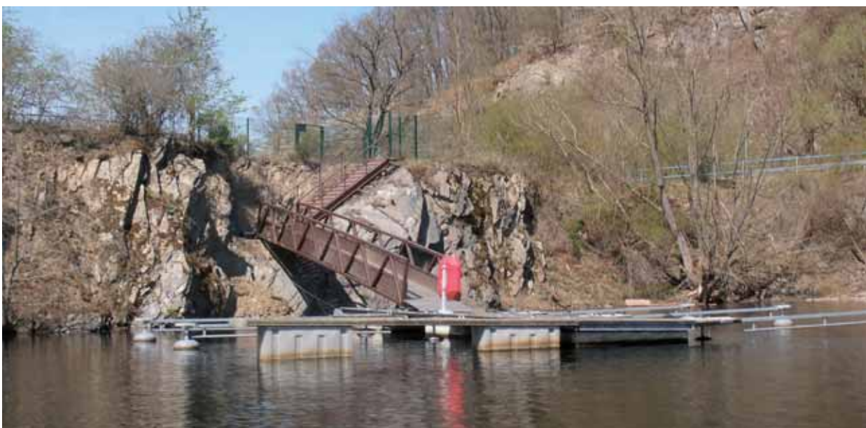
Neue Brücke zum Betriebs- und Anglersteg am Obersee der Rurtalsperre
