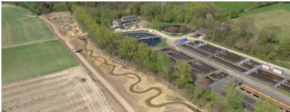
Renaturierter Haarbach neben der Kläranlage Eilendorf nach Fertigstellung der Erdarbeiten im Luftbild
