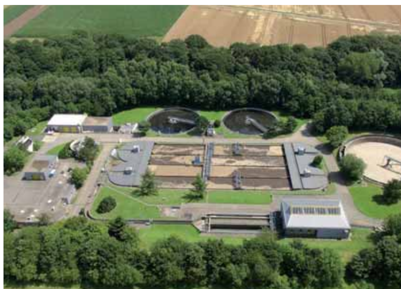
Luftbild der Kläranlage Euchen
