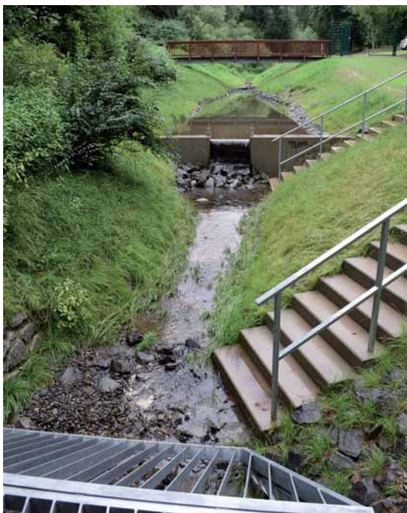
Neue Holzbrücke (im Hintergrund), neuer Sandfang und neuer Rechen am Gillesbach vor der Bahnunterführung in Burtscheid
