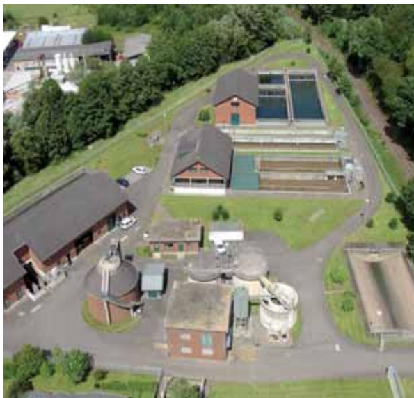
Abb. links: Kläranlage Schleiden
