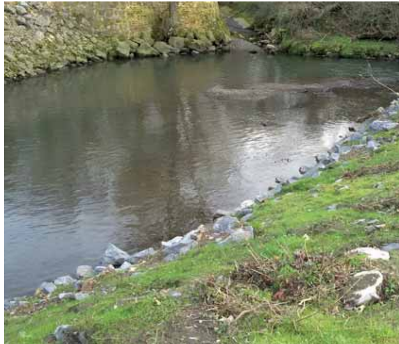
Neues Wurmufer in Höhe Wolfsfurt nach Abriss der Ufermauer
