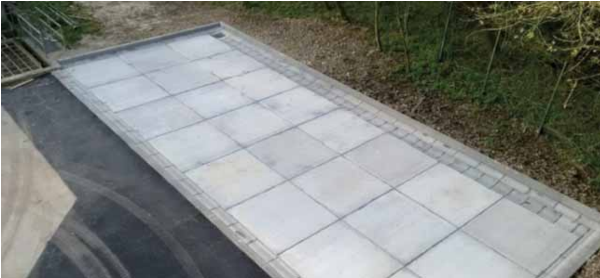
Erstellte Abtropf- flächen auf der ehemaligen Klär- anlage Siersdorf
