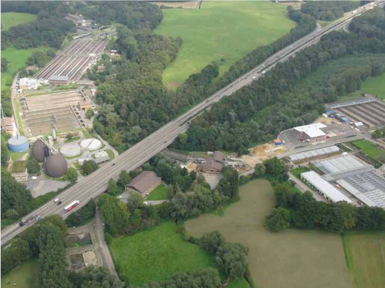
Die Kläranlage Aachen-Soers zieht sich entlang des Wurmtes bei Aachen
