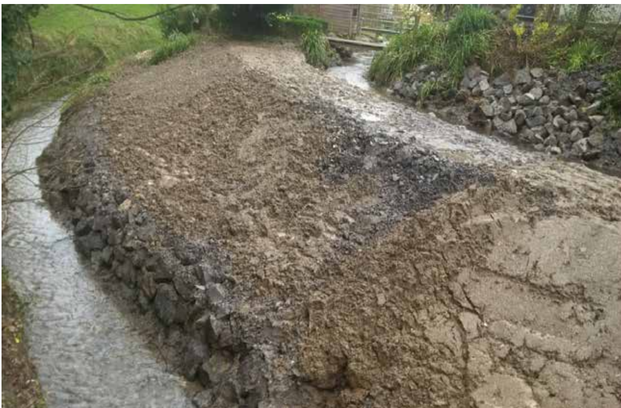
Neuer Trenndamm des unteren und des oberen Laufs des Wildbach in Aachen-Soers
