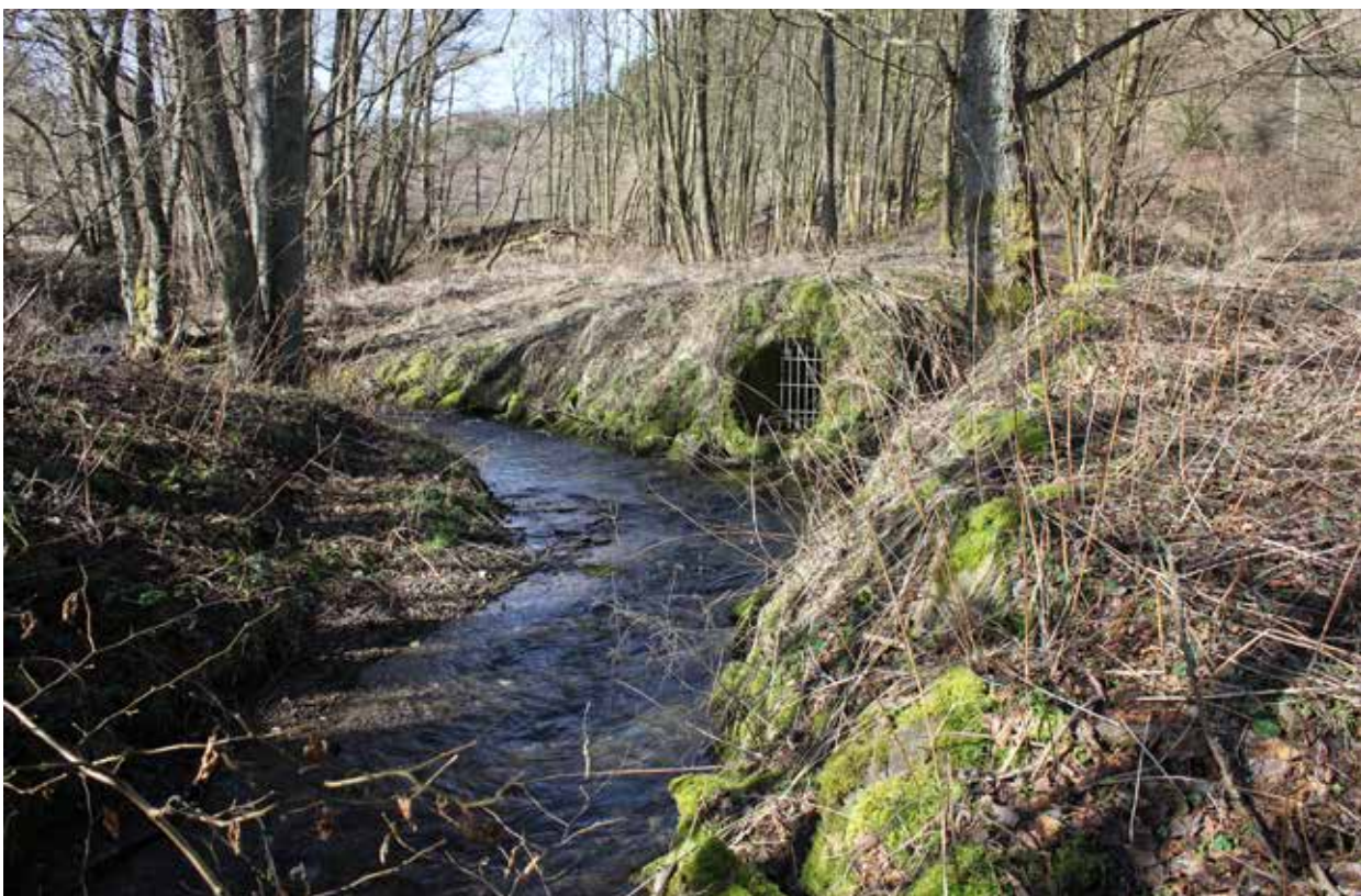
Einleitstelle des RÜB Schafbachmühle in den Dieffenbach (Schafbach)
