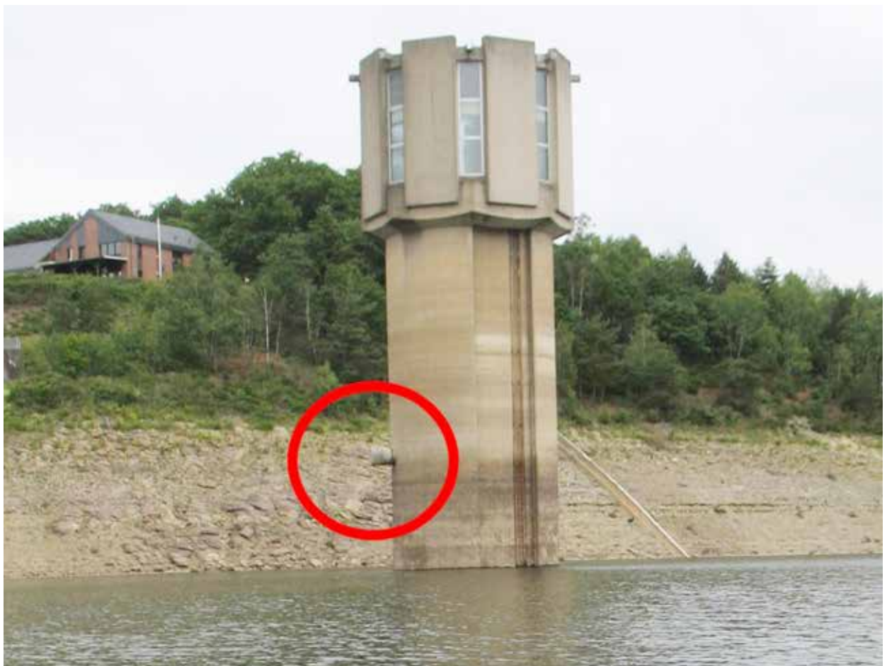
Wehebachtalsperre im Juni 2014: Der oberste der 4 Rohwasserseiherr des Entnahmeturms ragt aus dem Wasser.
