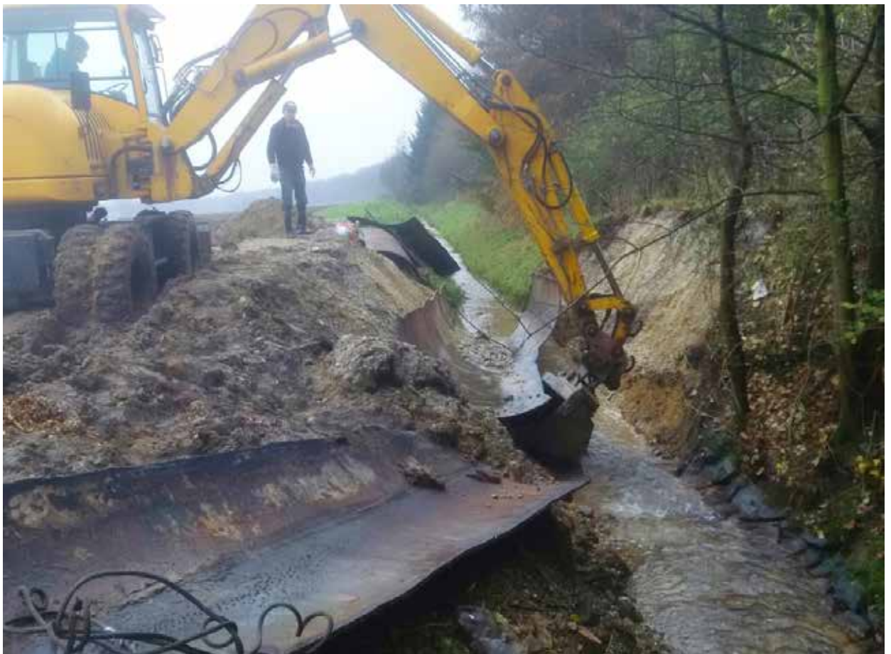
Entfernung eines alten Durchlasses aus dem Merzbach
