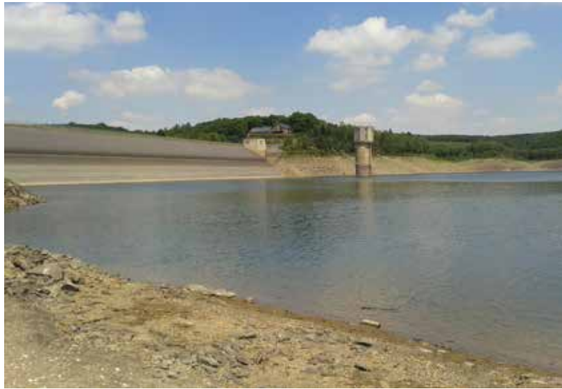
Niedriger Wasserstand in der Wehebachtalsperre am 02. Juli 2014
