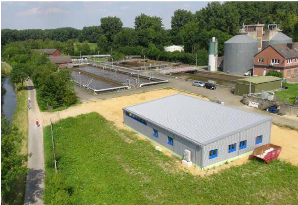
Luftbild der Kläranlage Geilenkirchen mit neuem Gebäude
