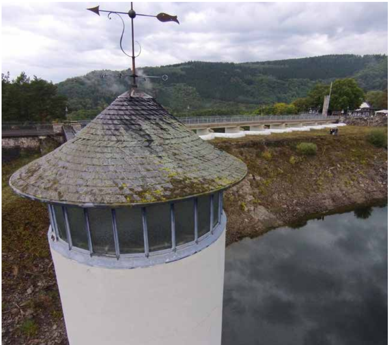
Foto von einer Drohne aus im Anflug auf einen Schieberturm an der Urtftalsperre
