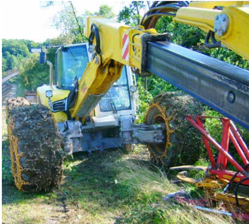
Entförsterungsarbeiten am luftseitigen Dammkörper der Wehebachtalsperre mit einem Schreitbagger, der auch in steilen Hängen arbeiten kann
