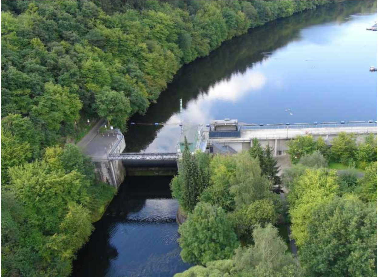
Luftbild des Staubeckens Heimbach; die Fischbauchklappe befindet sich in der linksseitigen Hochwasserentlas- tungsanlage
