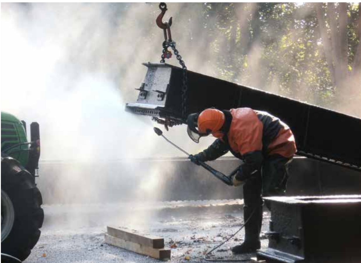
Überarbeitung eines aus dem Obersee entnom- menen Damm- balkens
