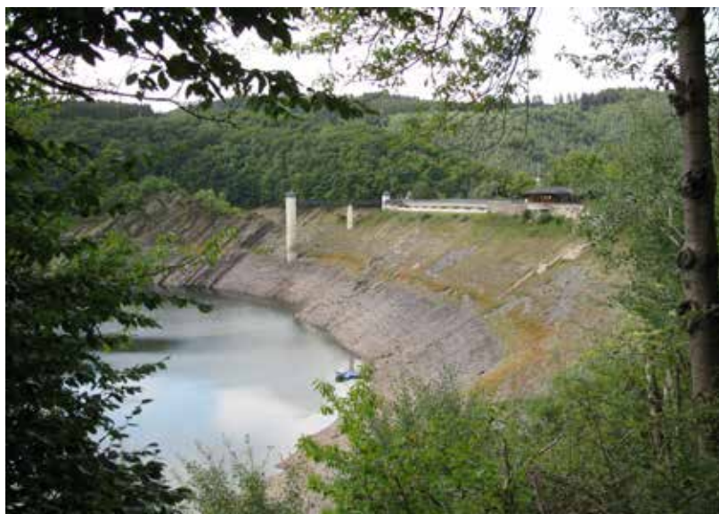
Dank niedrigem Wasserstand freistehender HE-Turm an der Urfttalsperre
