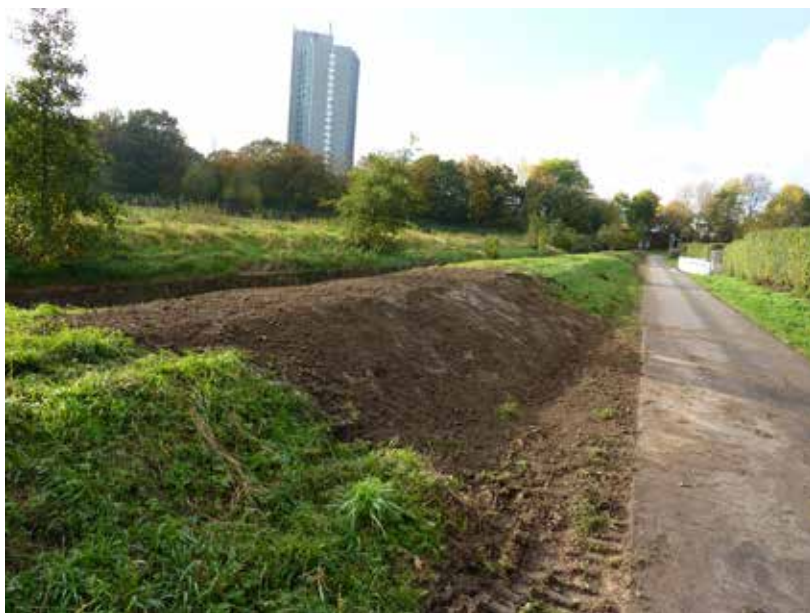
Aufgefüllte Verwallung an der Wurm
