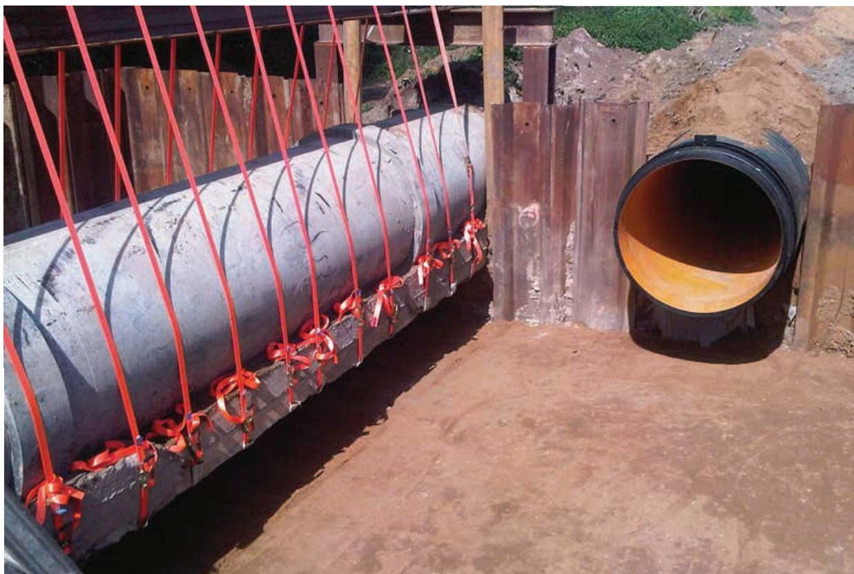
Zur Errichtung eines Schachtbauwerks mit Rohrbettung aufgehängter bisheriger Sammler
