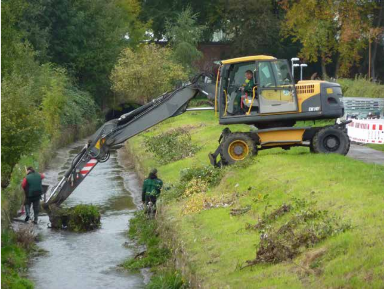
Räumung des Kastenprofils der Wurm
