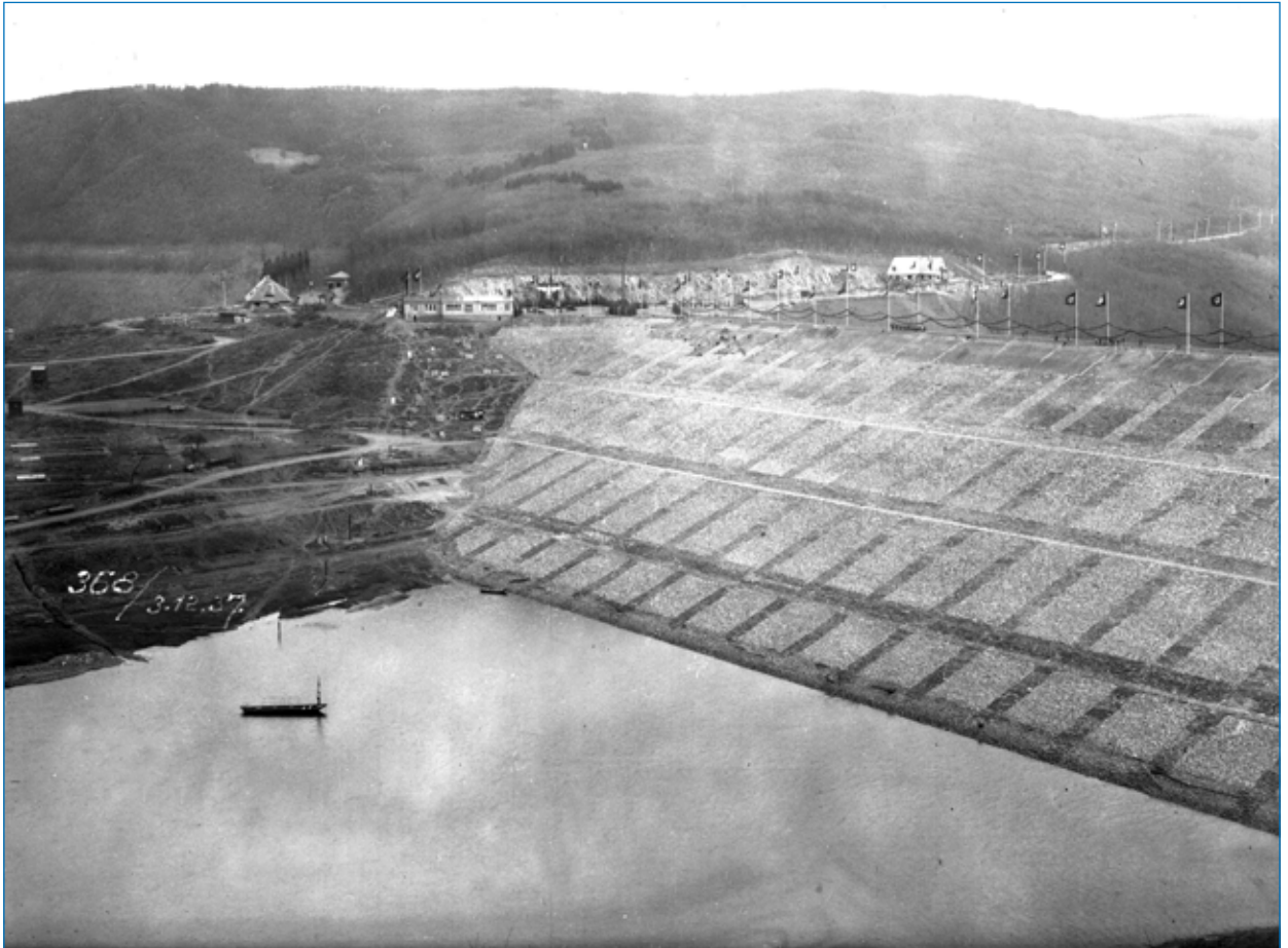
Die Rurtalsperre Schwammenauel bei ihrem ersten Ausbau von der Wasserseite aus gesehen (Foto vom 3.12.1937)
