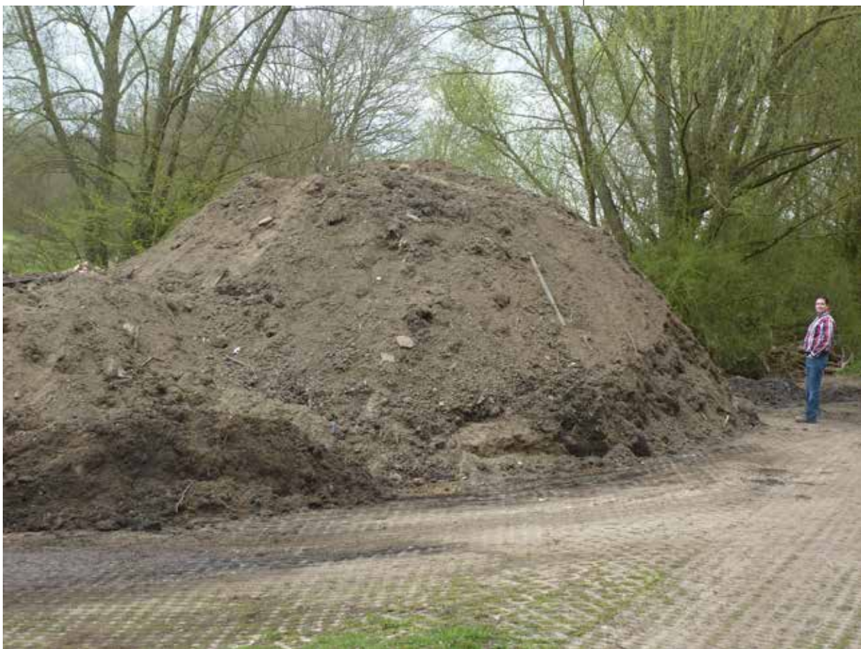
Trocknung des aus dem verrohrten Haarbach entnom- menen Sediments
