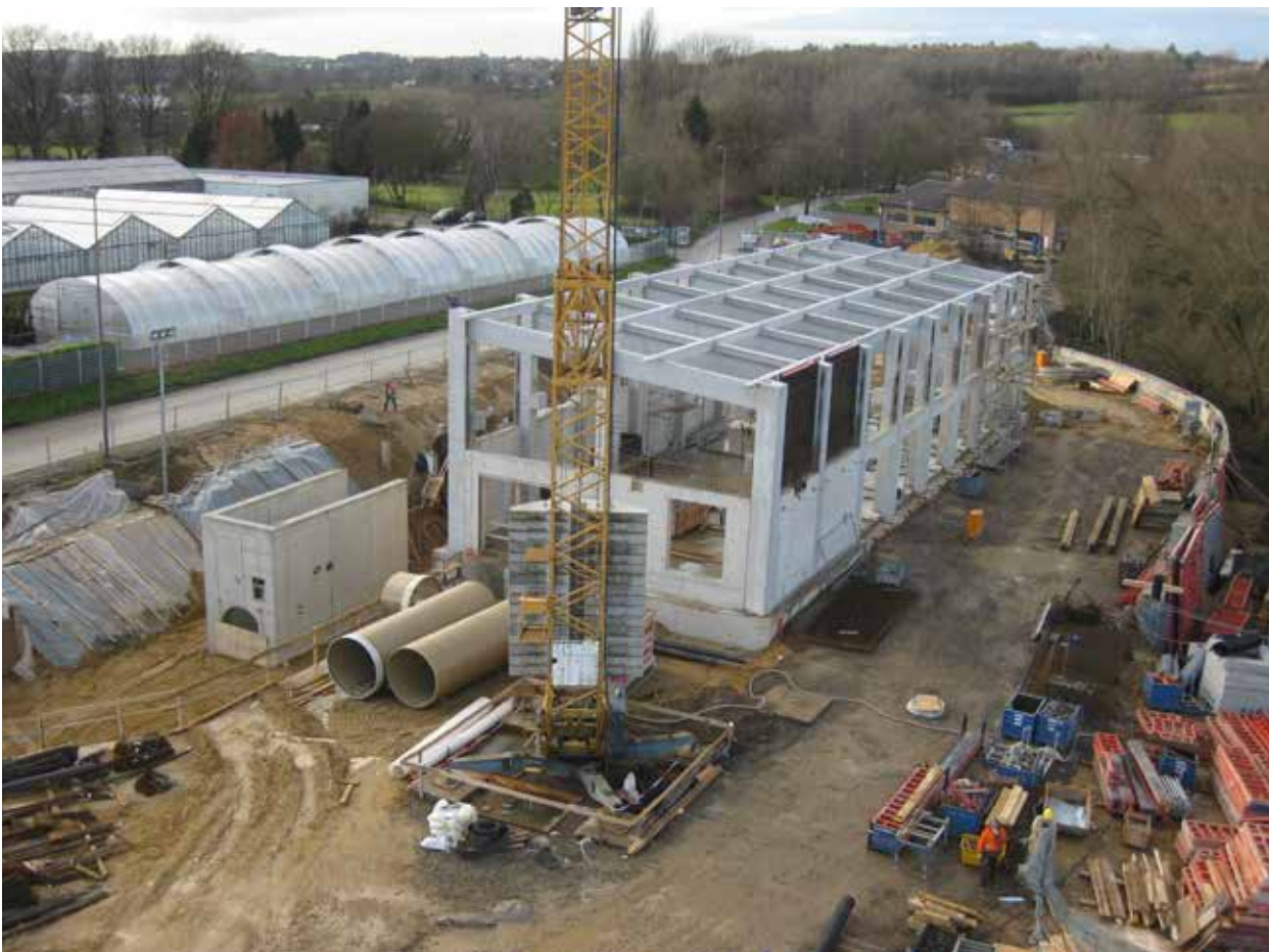
Baustelle des neuen Rechen- gebäudes an der Zufahrt zur Kläranlage Aachen-Soers gegenüber der Aachener Stadtgärtnerei
