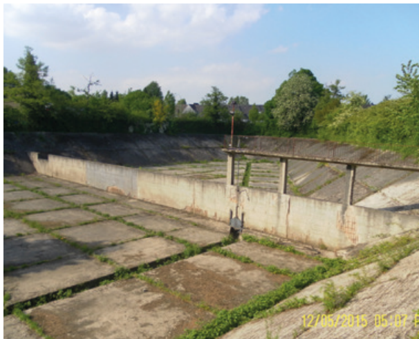
Abb. links: RRB Otto-Hahn-Straße in Baesweiler vor der Sanierung
