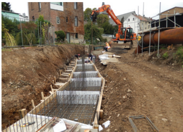
Abb. links: Arbeiten am Ortbetonfundament im Lendersdorfer Mühlenteich; am rechten Bildrand sieht man die Heberleitung
