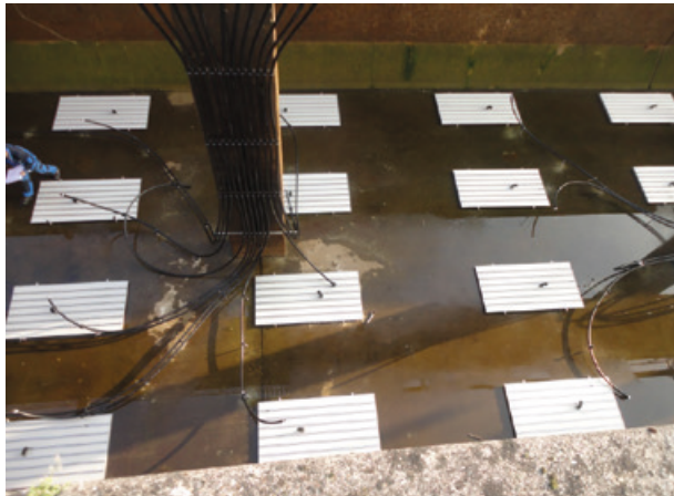
Abb. links: Neu eingebaute Membranbelüf- terplatten in der Belebung der Klä- ranlage Aachen- Soers
