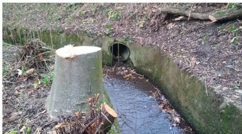
Betoniertes Profil des Gillesbaches mit Einleitstelle aus einer Entwäs- serungseinrichtung
