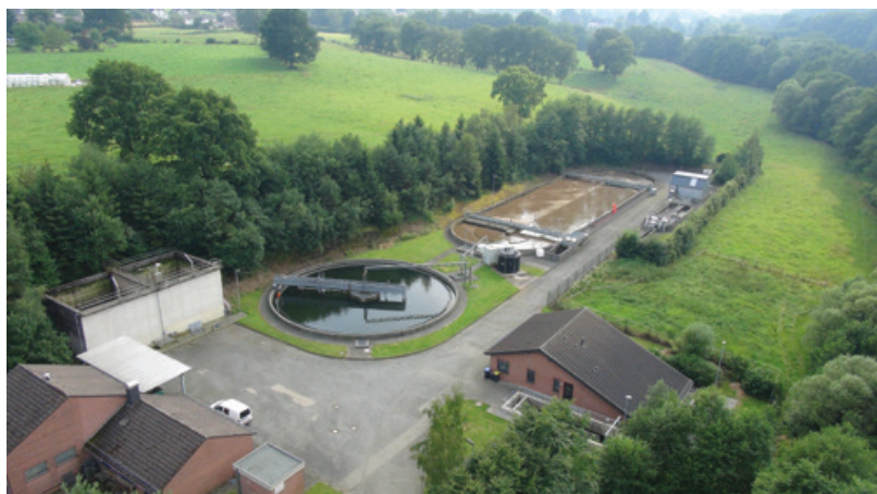
Kläranlage Roetgen: Die Probenahme erfolgte im Zulauf zum Belebungsbecken (hinten) nach Rechen und Sandfang.
