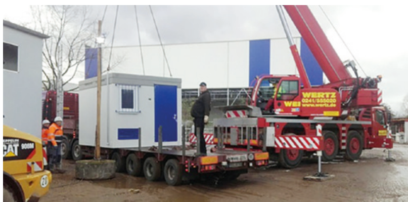
Aufsetzen des neuen Messhauses der erneuerten Mess- und Probenahmestation bei der Firma Schoellershammer
