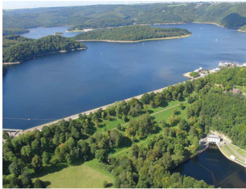
Damm der Rurtalsperre Schwammenauel von der Luftseite aus gesehen
