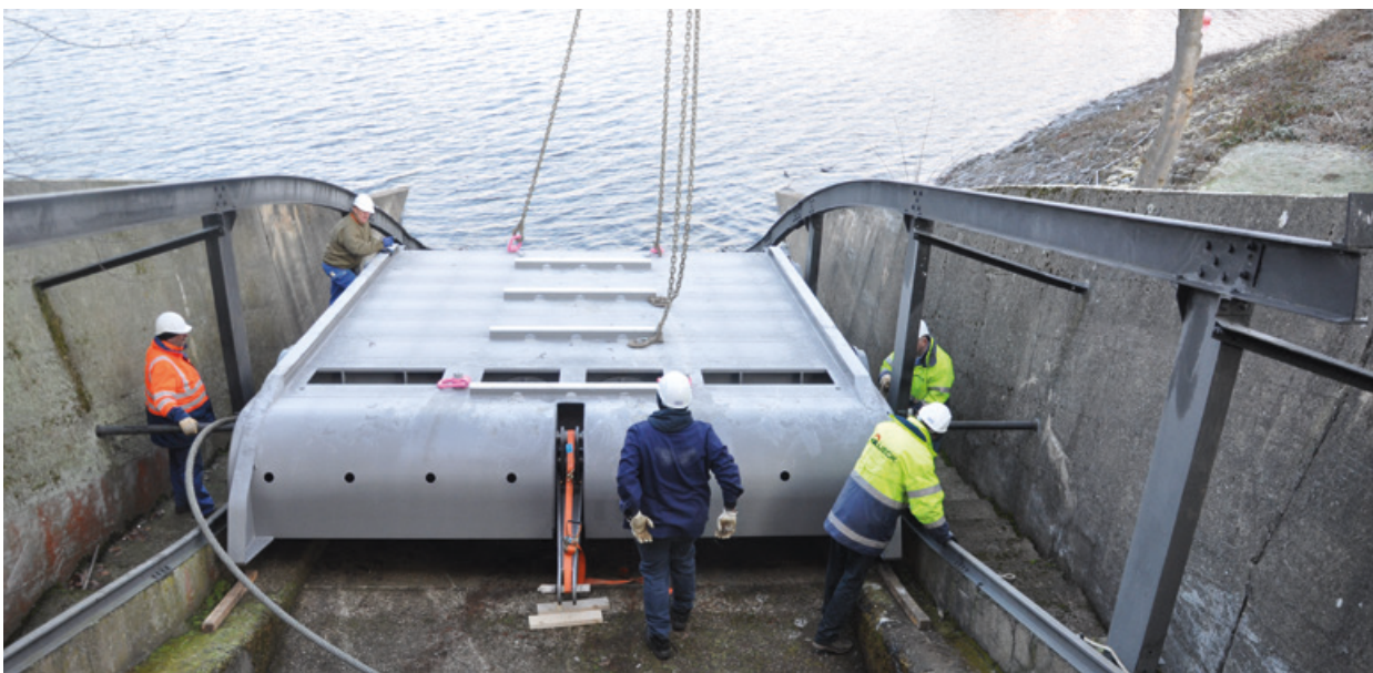
Einsetzen des neuen Rollschützes an der Rurtalsperre Schwammenauel
