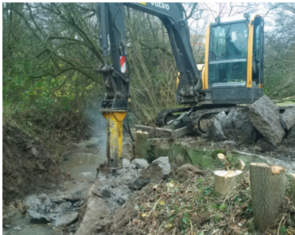
Abb. links: Aufbrechen der Betoneinfassung des Gillesbachs
