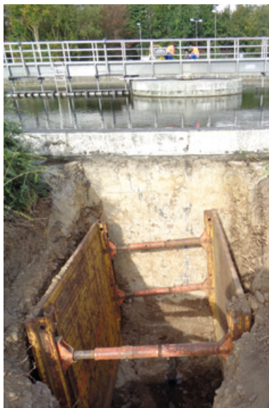
Abb. links: Schachtung zur Feilegung eines gebrochenen Kabels an der Stromzuleitung eines Räumers der Kläranlage Eschweiler
