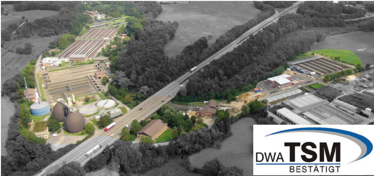
Die Kläranlage Aachen Soers stand im Zentrum der TSM-Prüfung
