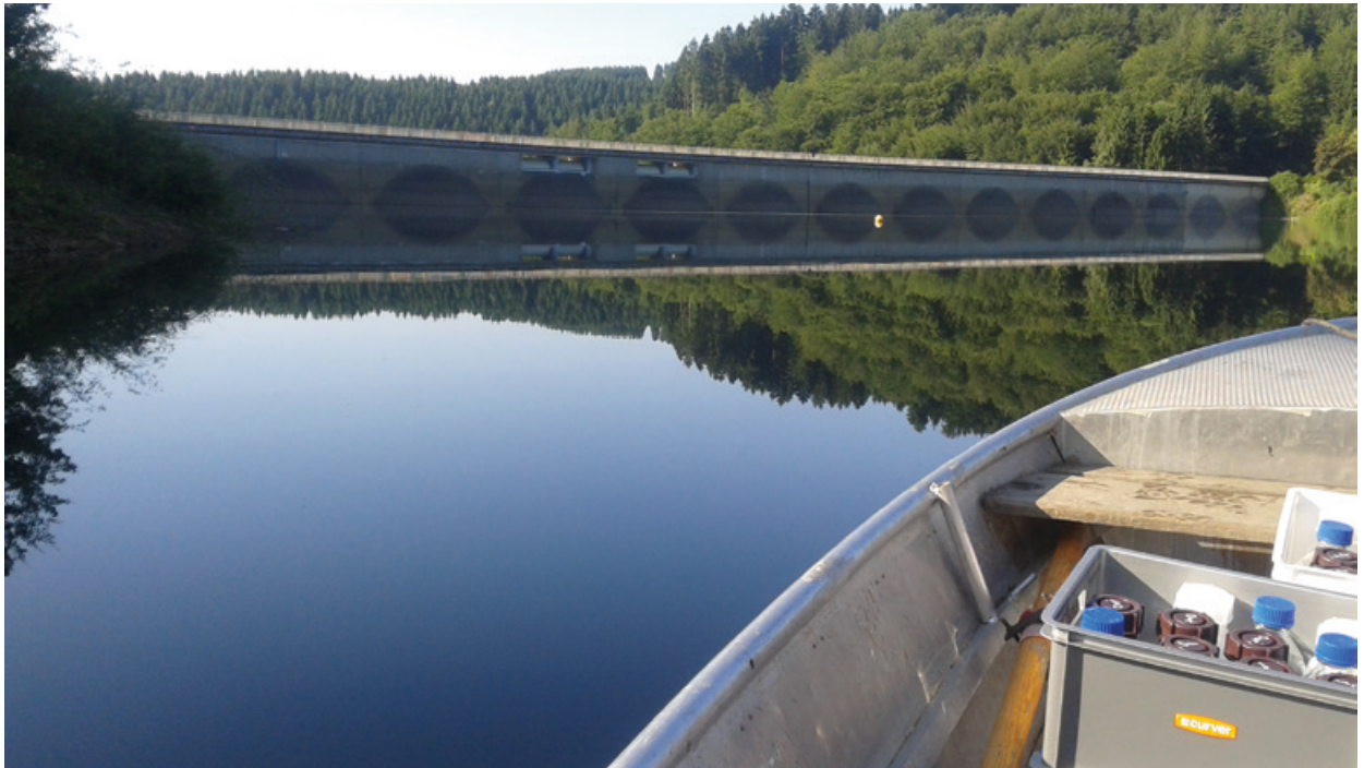
Mauer der Oleftalsperre und Probenahmeboot
